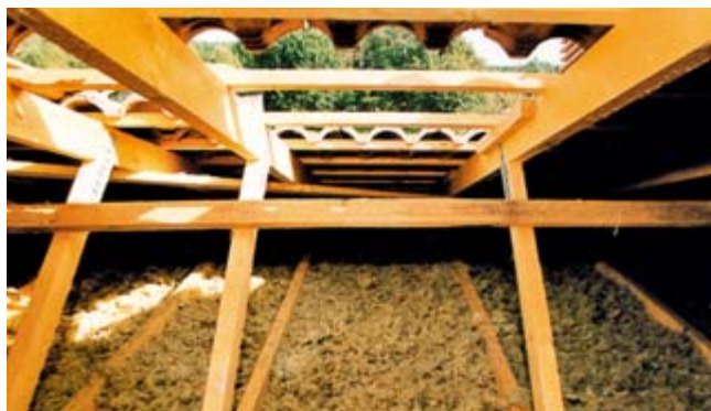
Vazníková střecha – izolace stropu (obr. 15)
