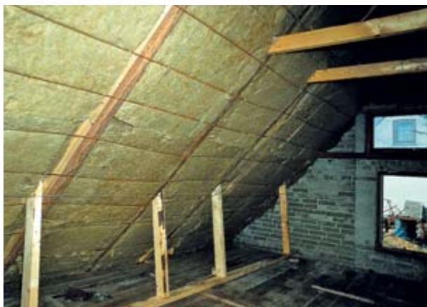
Ještě zbývá doplnit izolaci pod krokvy (obr. 13)
