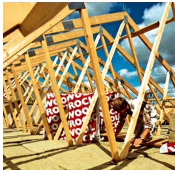
Konstrukce se zateplným stropem (obr. 12)
