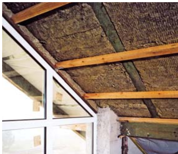
Provádění zateplení mezi krokvemi (obr. 4)
