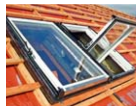
Montáž střešního okna (obr. 22)
