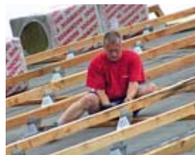
Vložení přidavné krokve do kovového držáku (obr. 21)
