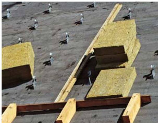
Pokládka izolace u systému TOPROCK (obr. 18)
